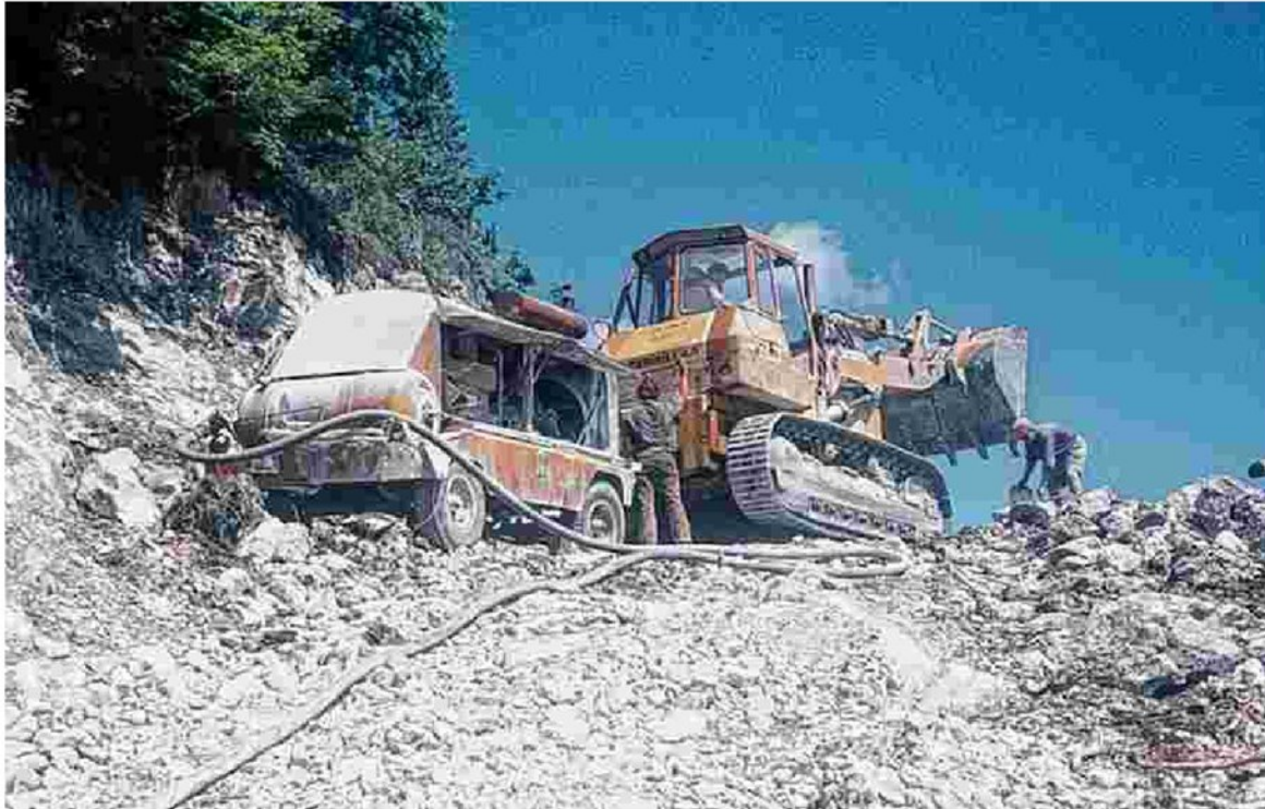
Ende der Sechzigerjahre begannen die Bauarbeiten an der Panoramastraße.
